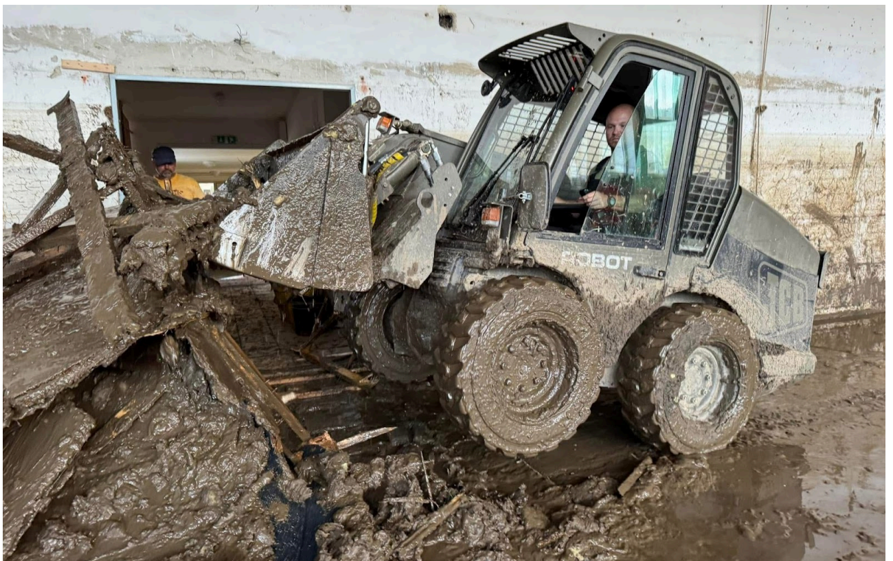
vyklízení podlahy v tělocvičně
